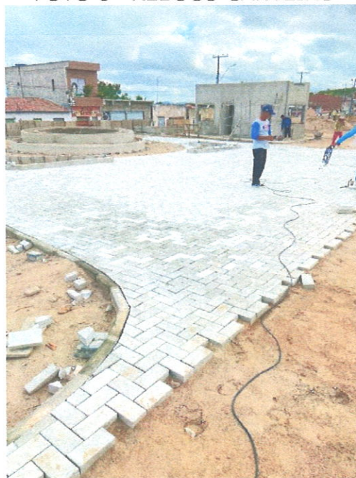
FOTO 9 - EXECUÇÃO DE INTERTRAVADO
