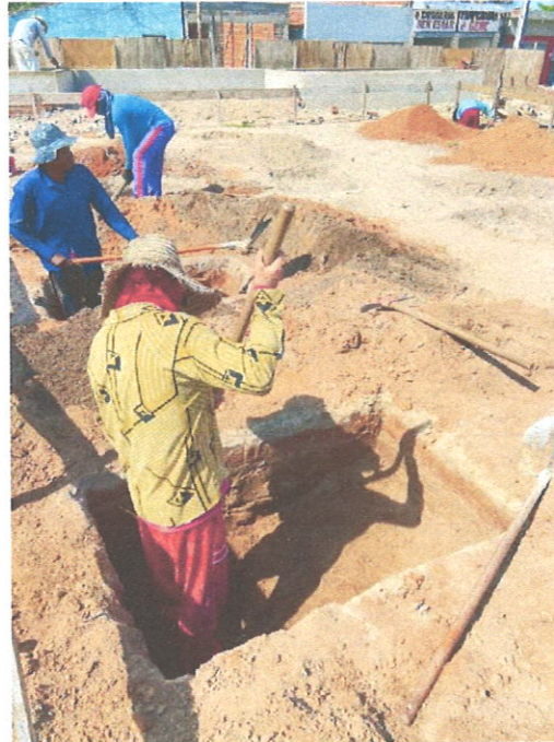
FOTO 1 – ESCAVAÇÃO MANUAL DE SAPATA
