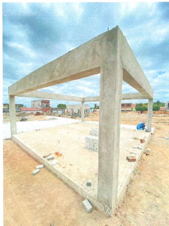
FOTO 7 – EXECUÇÃO DE ESTRUTURA
