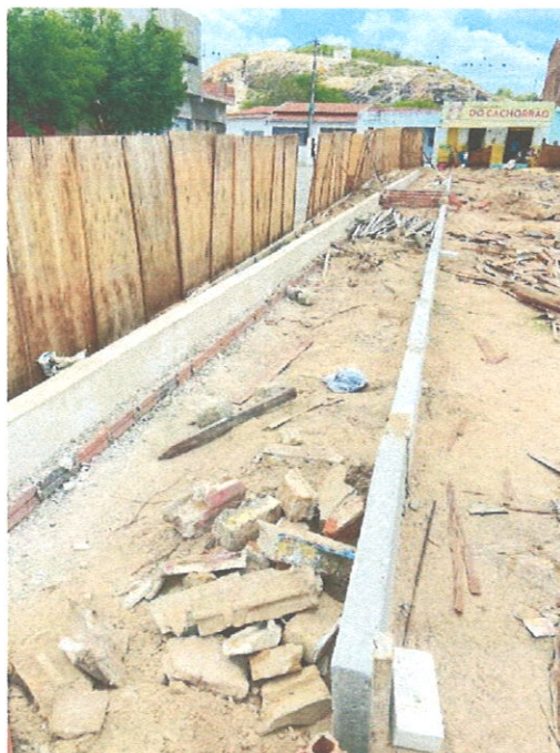
FOTO 10 - EXECUÇÃO DE MEIO FIO
